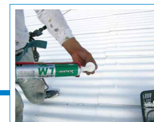
シーリングキャップ取付 シーリング充填専用キャップを取付。
