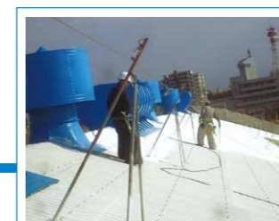
トップコート吹付 仕上げ塗装(白以外のカラー塗装も可能)をします。
