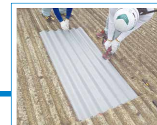
劣化部補修 劣化箇所を補修・取替え。
