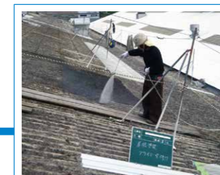
浸透プライマー塗装 乾燥させローラー・スプレーで行う。
